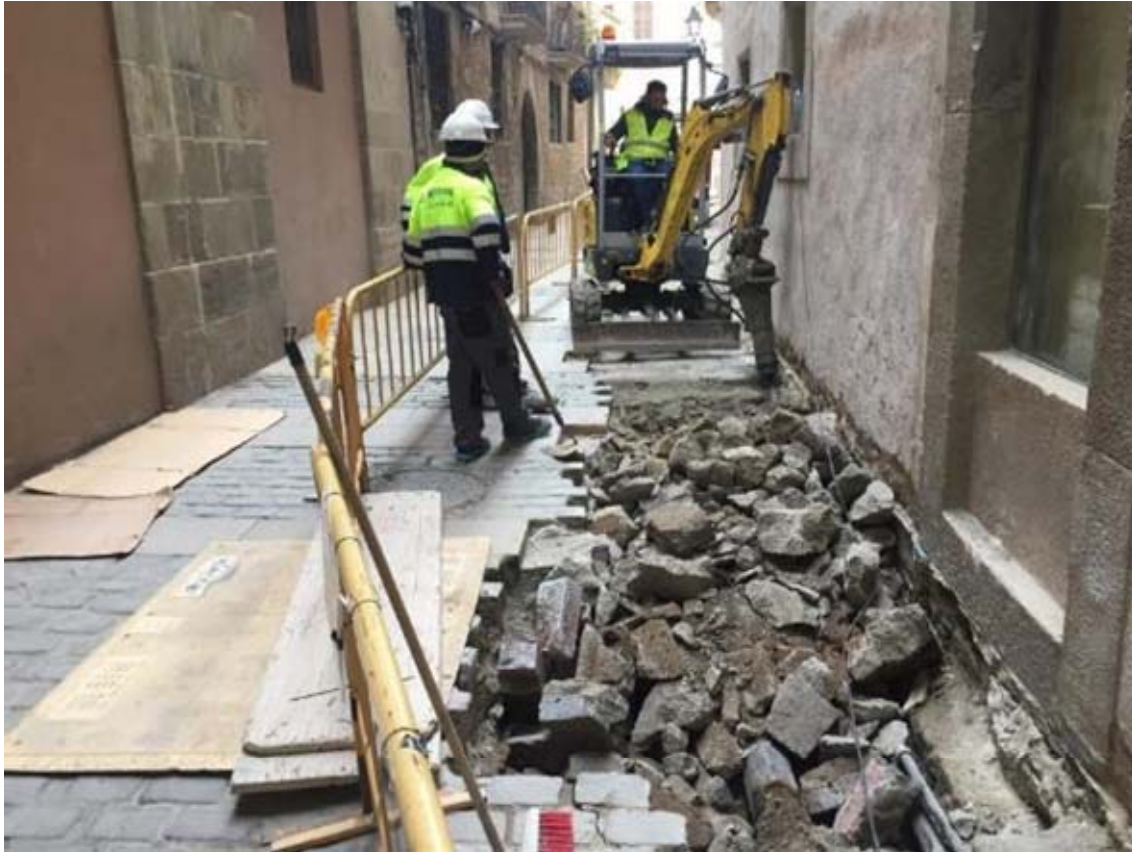
Foto 11: màquina giratòria de petit tonatge picant el ciment del carrer del Bisbe Caçador.
