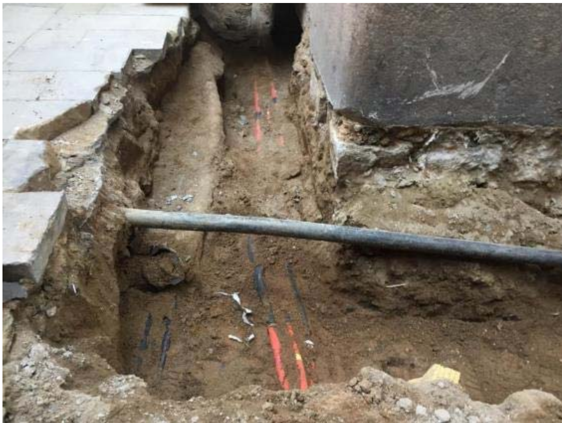
Foto 24: serveis destapats i cota assolida al tram de la rasa a la Plaça Sant Just.
