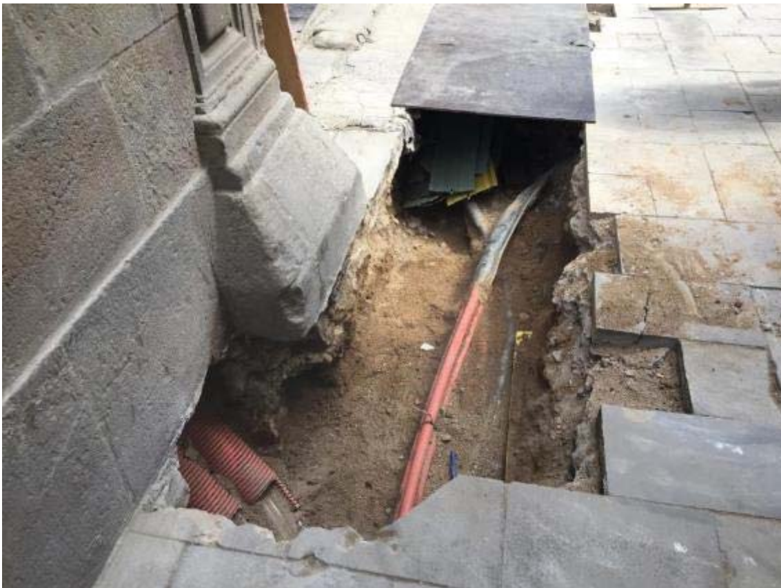
Foto 29: tram de rasa de la Plaça Sant Just acabada. Es poden veure els serveis localitzats.
