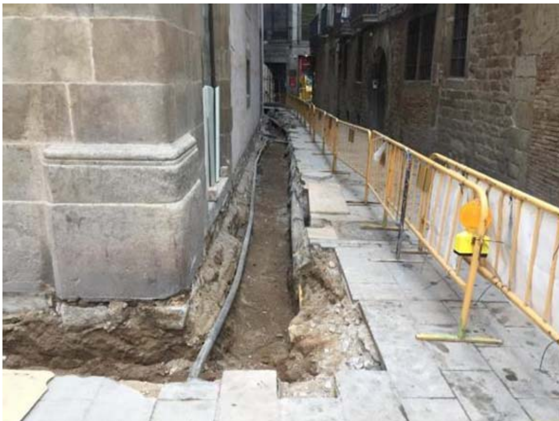
Foto 31: tram de rasa del carrer del Bisbe Caçador acabat.
