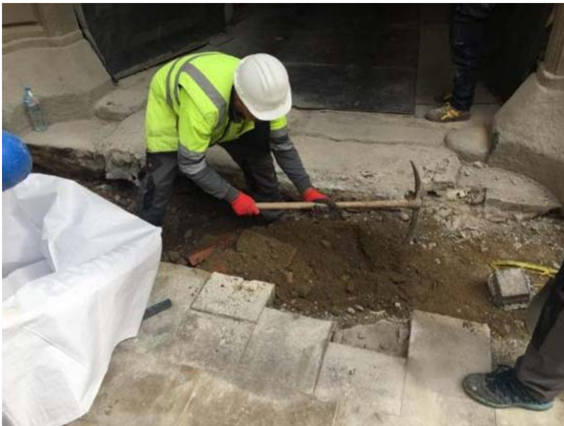
Foto 26: : operaris rebaixant la rasa a la Plaça Sant Just.
