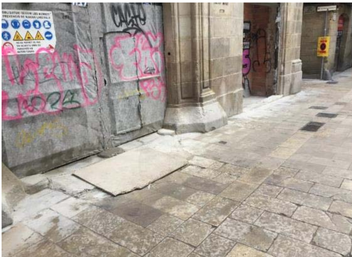
Foto 2: zona de la Plaça de Sant just on s'ha de realitzar la rasa.
