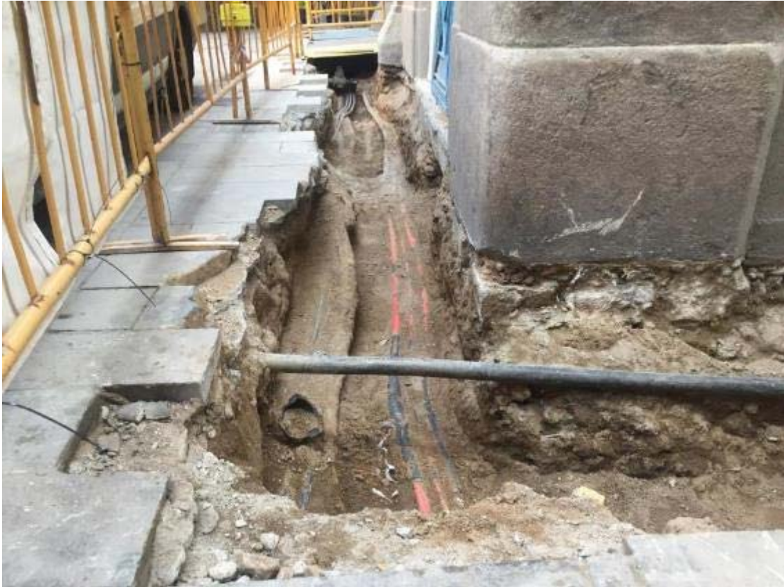
Foto 30: tram de rasa de la Plaça Sant Just acabada. Es poden veure els serveis localitzats
