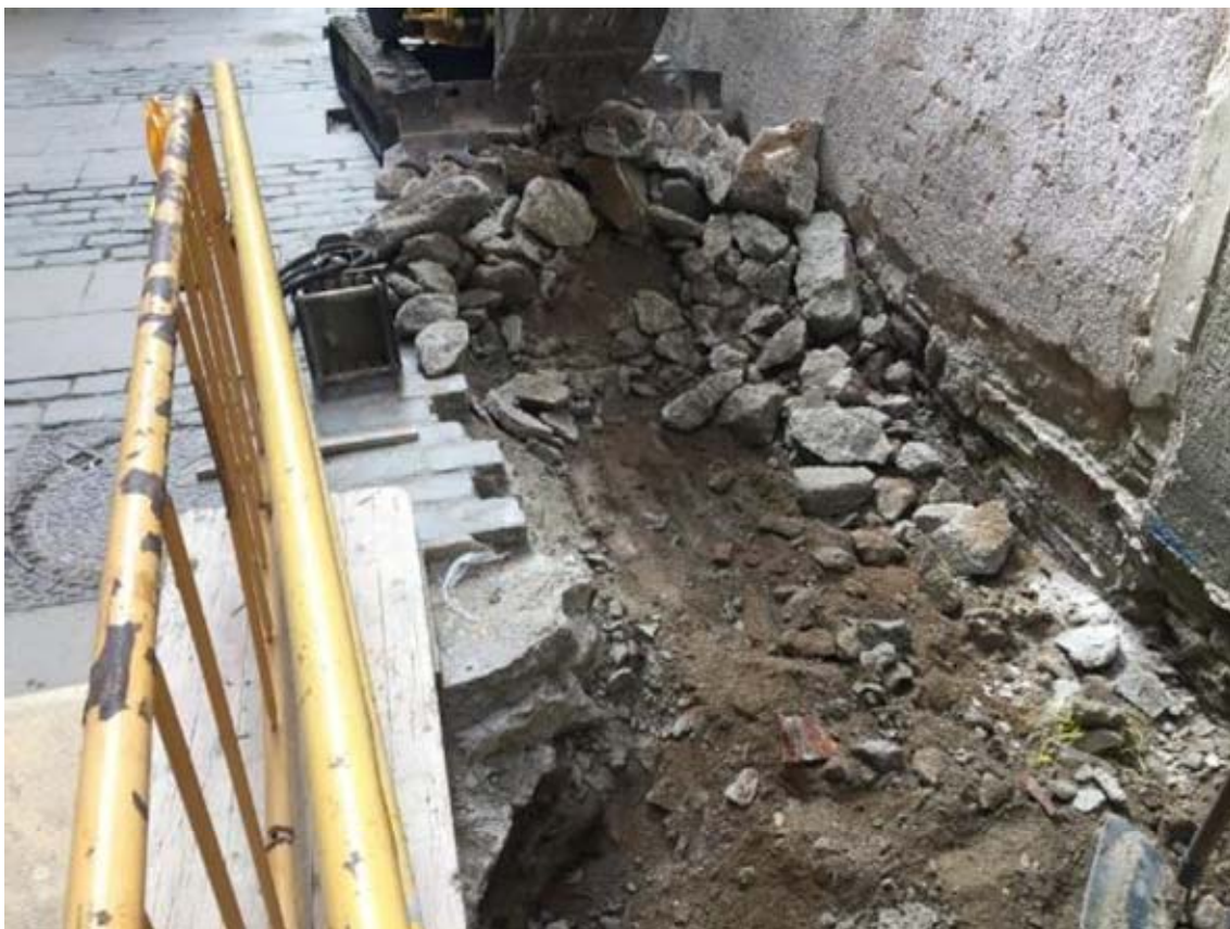
Foto 12: màquina recollint el ciment picat del carrer del Bisbe Caçador.
