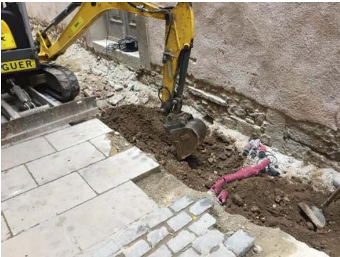
Foto 17: màquina extraient el gruix de terra.
