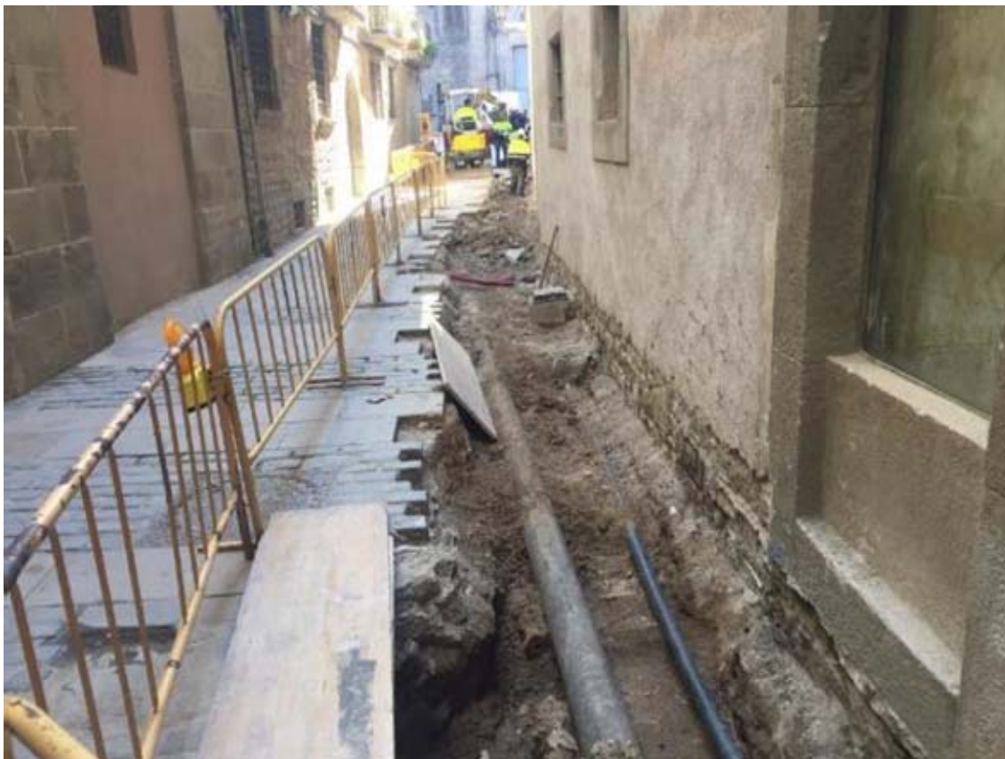
Foto 16: tram de rasa del carrer del Bisbe Caçador a punt de rebaixar. Es poden veure els serveis ja instal·lats en anteriors intervencions.
