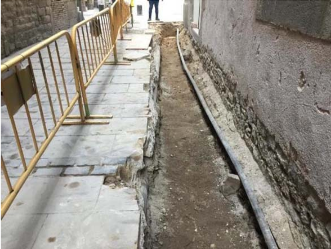
Foto 32: tram de rasa del carrer del Bisbe Caçador acabat.
