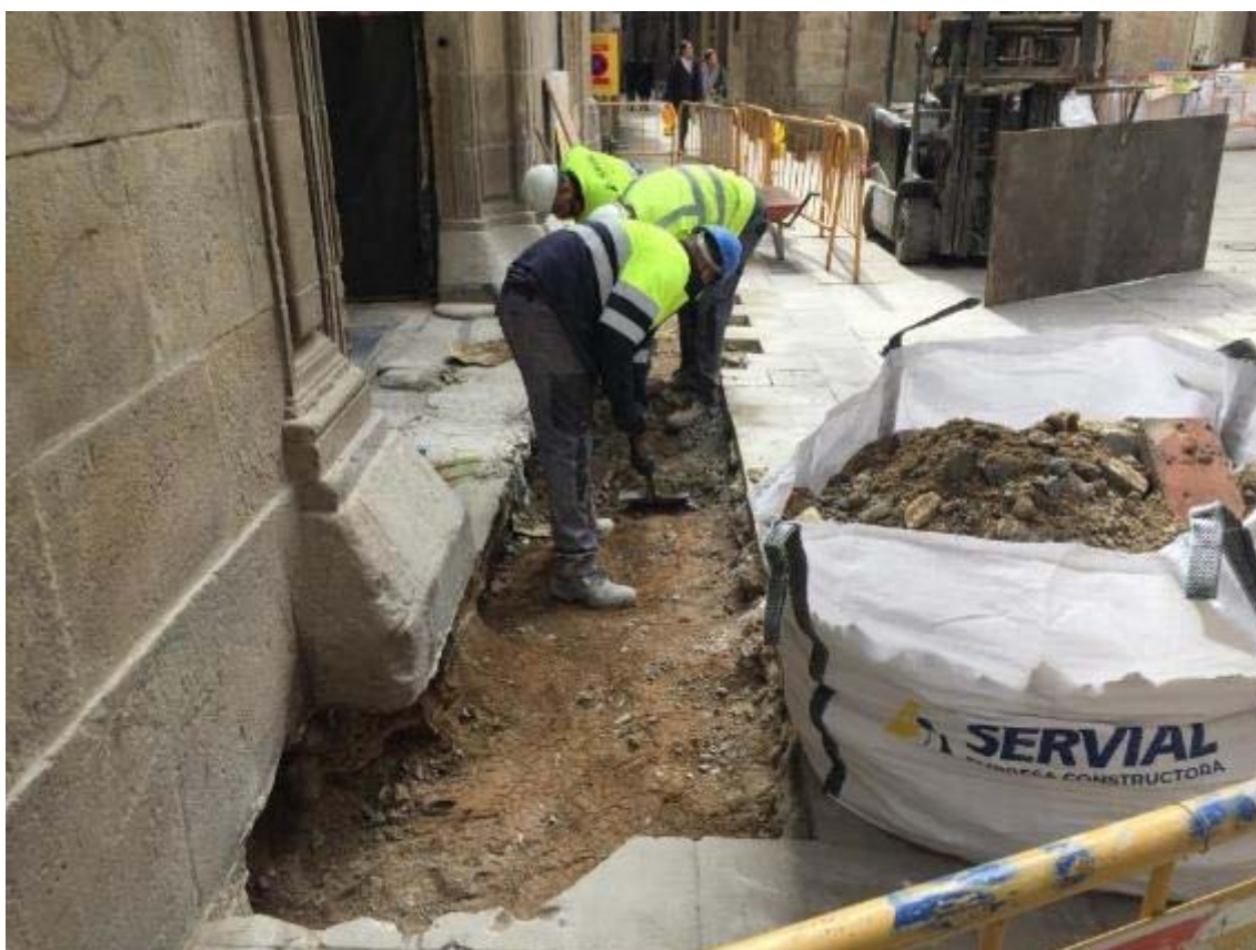
Foto 25: operaris rebaixant la rasa a la Plaça Sant Just.
