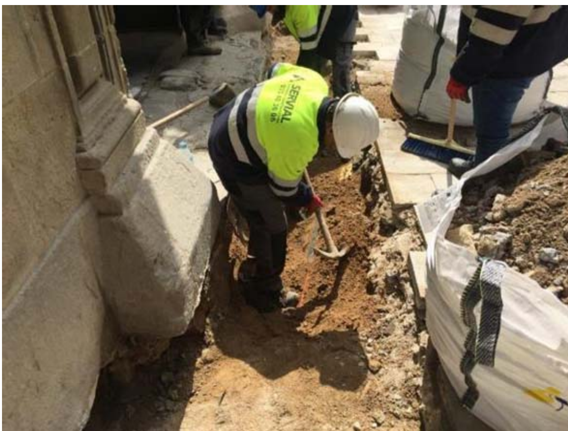
Foto 27: : operaris rebaixant la rasa a la Plaça Sant Just.
