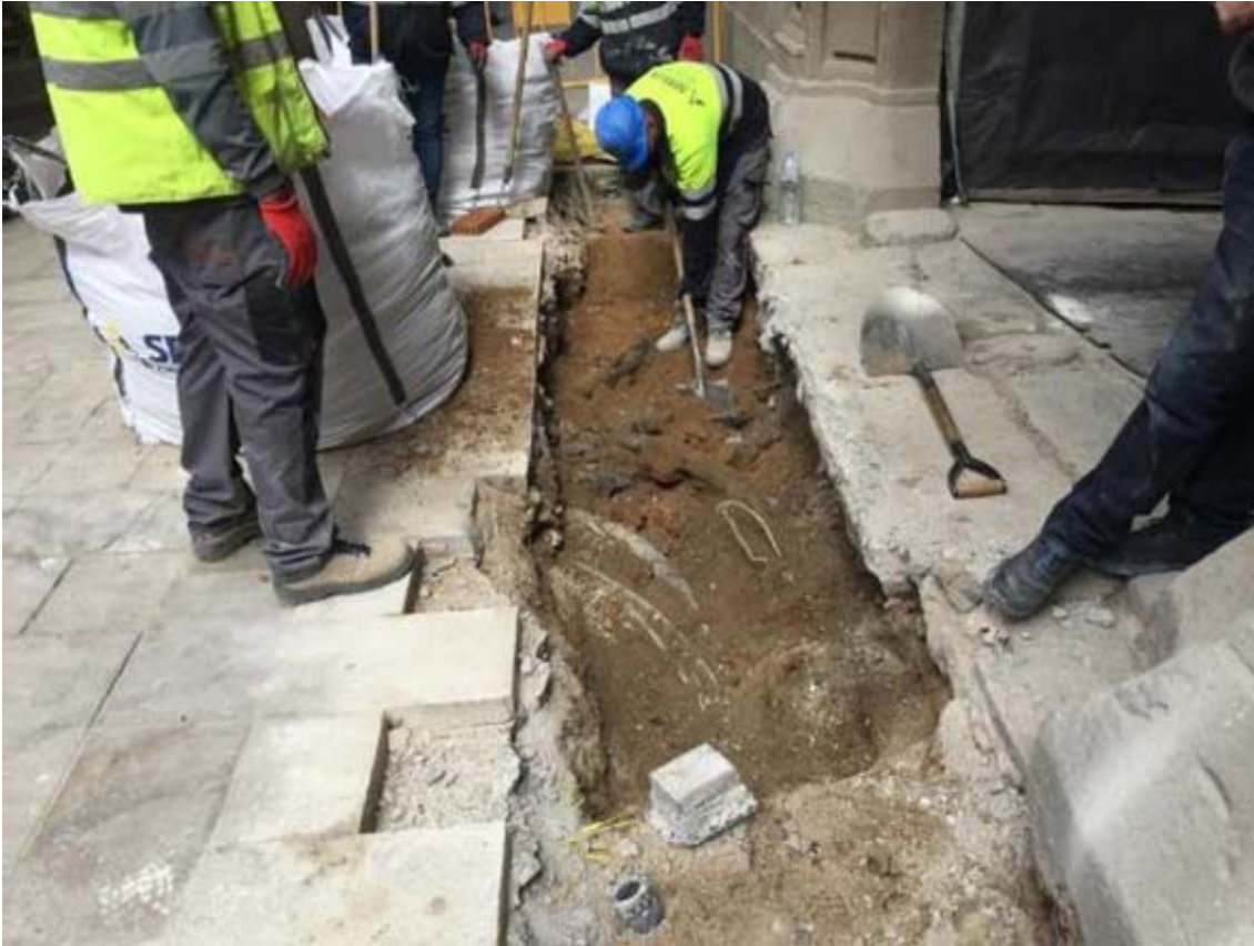
Foto 28: : operaris rebaixant la rasa a la Plaça Sant Just.
