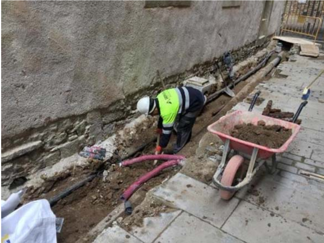
Foto 20: operari extraient terra i destapant serveis del carrer del Bisbe Caçador.
