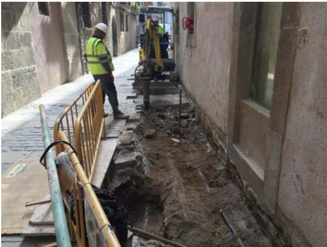
Foto 13: màquina giratòria de petit tonatge picant el ciment del carrer del Bisbe Caçador.
