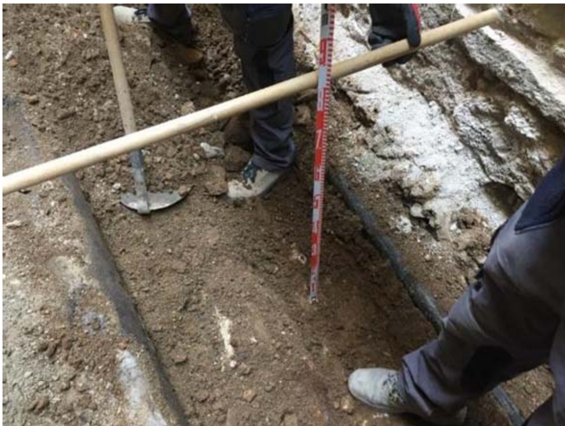
Foto 19: cota de profunditat de la rasa, coincident amb la part baixa dels serveis localitzats.
