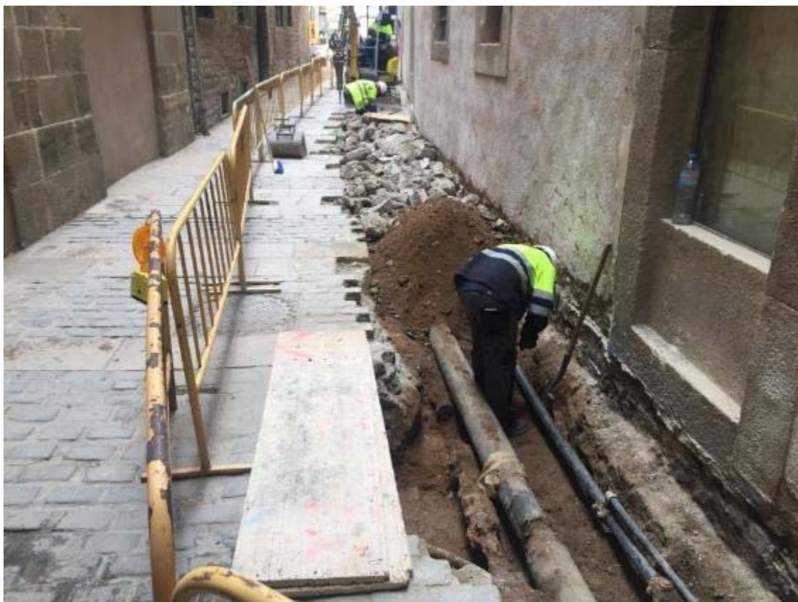
Foto 14: operari extraient terra i destapant serveis del carrer del Bisbe Caçador.
