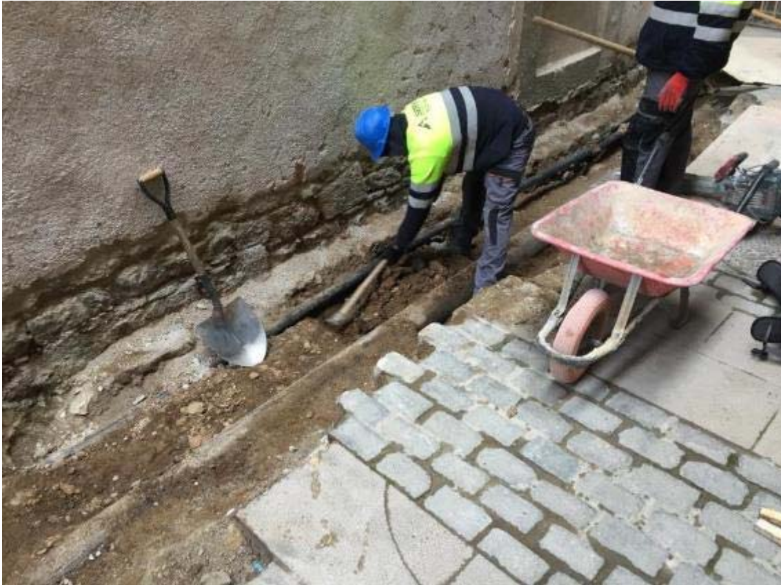
Foto 18: operari extraient terra i destapant serveis del carrer del Bisbe Caçador.
