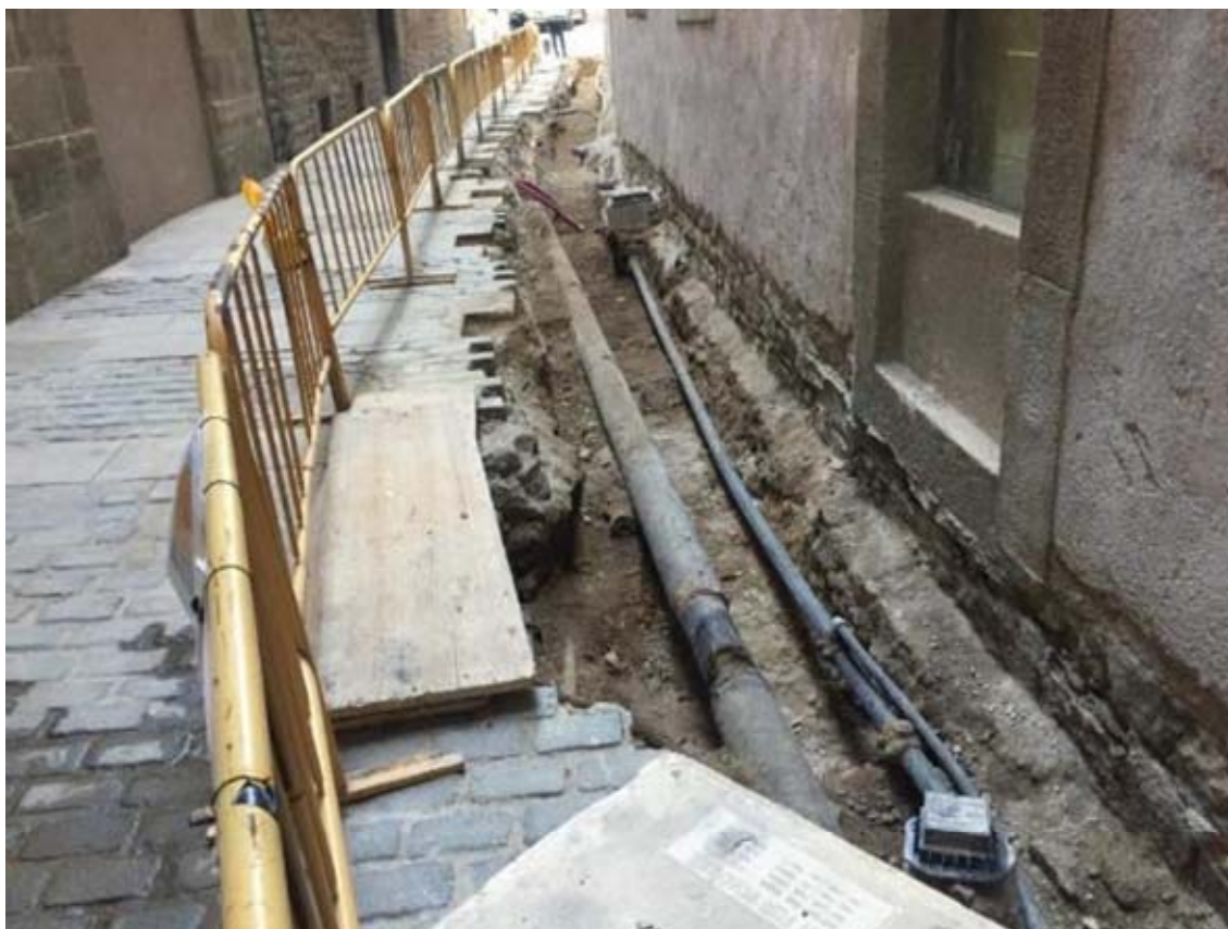
Foto 34: tram de rasa del carrer del Bisbe Caçador acabat.
