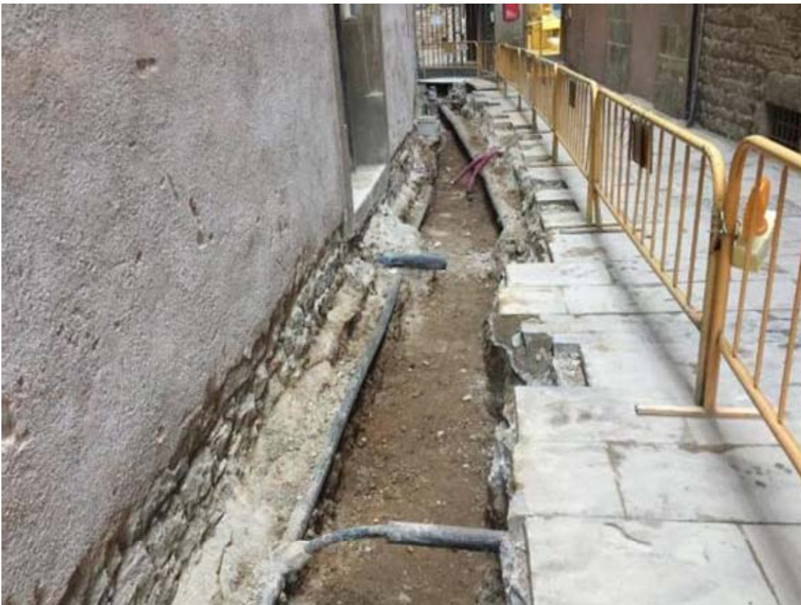
Foto 33: tram de rasa del carrer del Bisbe Caçador acabat.
