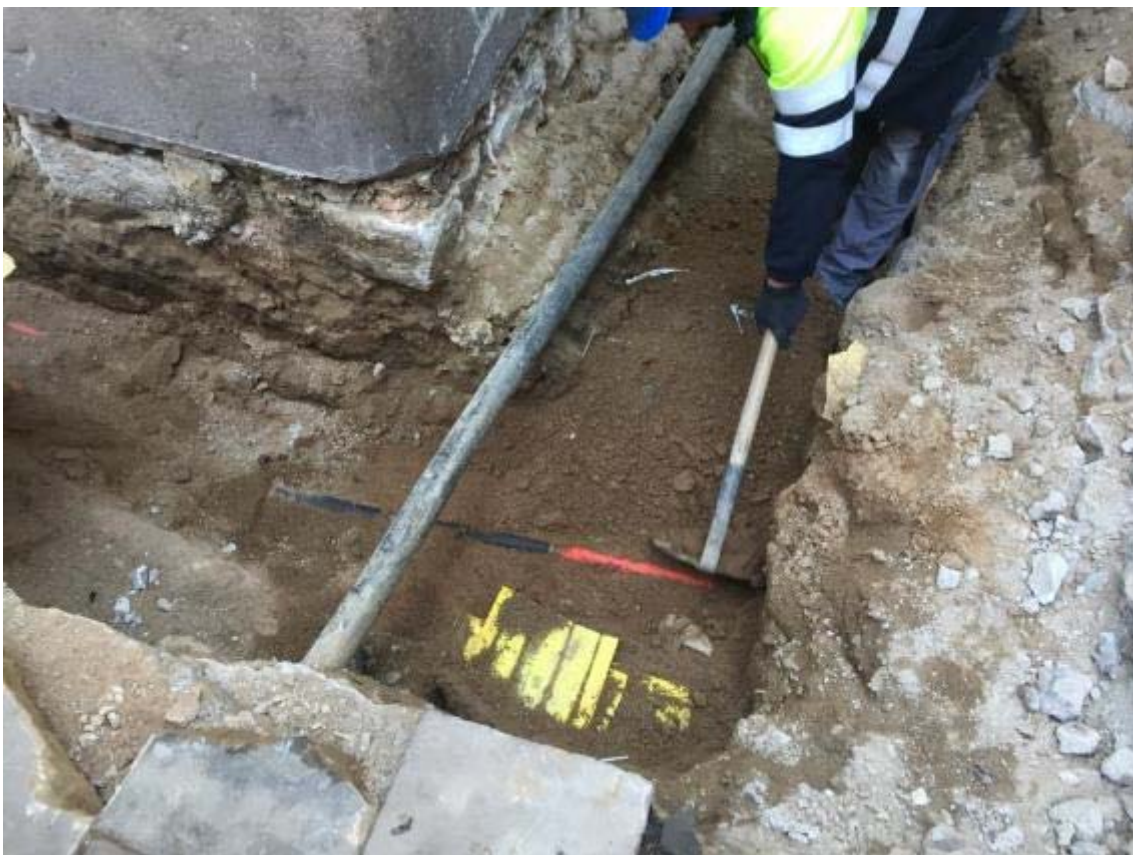
Foto 23: operari rebaixant i destapant serveis a la Plaça Sant Just.
