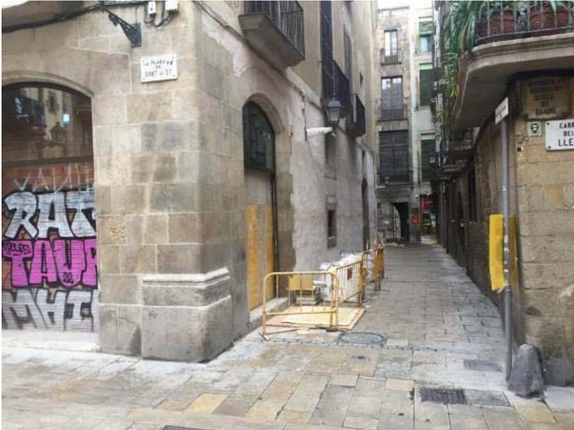
Foto 3: cantonada de Plaça de Sant Just amb el carrer del Bisbe Caçador, però passarà la rasa.
