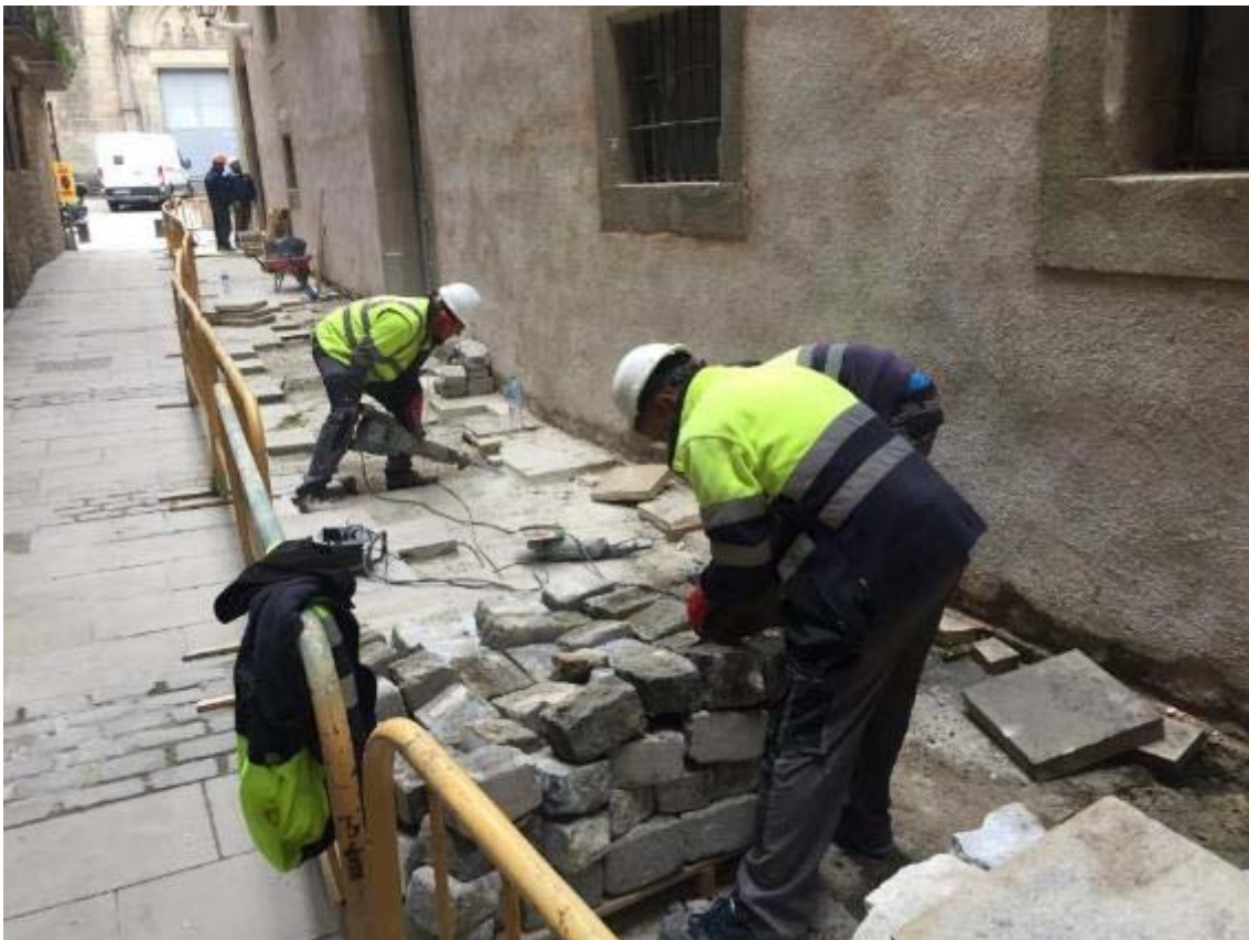
Foto 10: operaris extraient el paviment del carrer del Bisbe Caçador.
