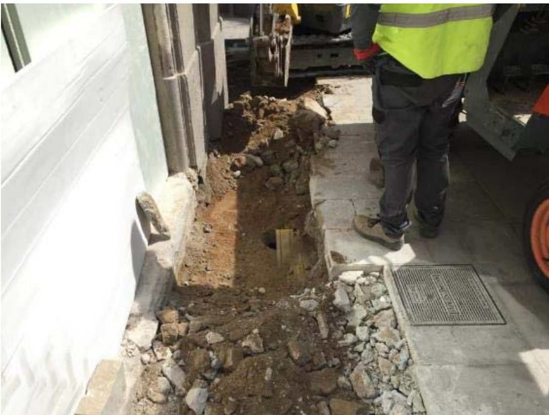
Foto 21: extracció del ciment picat al tram de rasa de la Plaça Sant Just.
